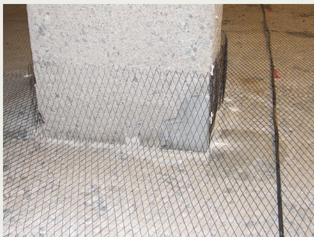
Figur 3. Montering av anodnät av titan på betonggolv och nedre del av pelare i parkeringsgarage.
